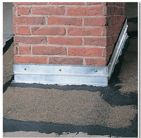
Kappeleiste am Schornstein mit SCHWARZER BLOCKER SPACHELMASSE und Bitumenbahn abgedichtet.
