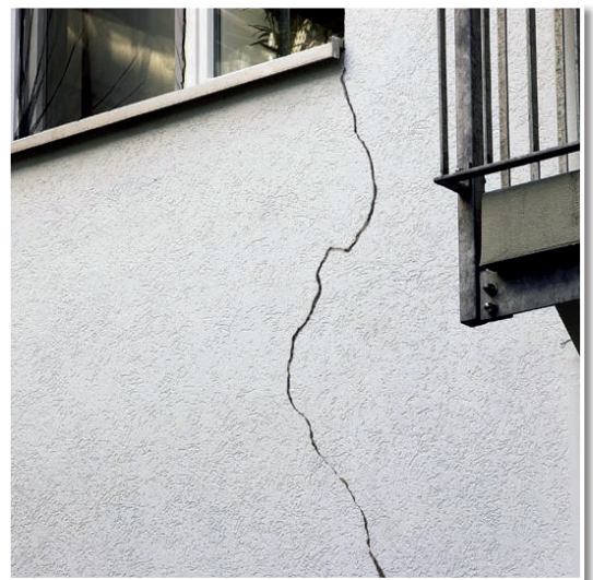
Typisches Objekt für den Rissverschluss mit RISS-STOPP WAND + FASSADE.
